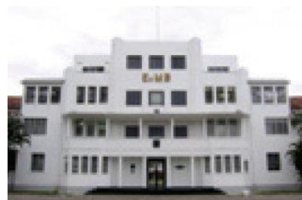
Fachada da EsMB
